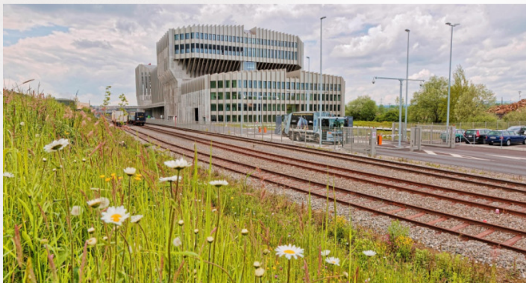
Die Anlage von Renergia in Perlen. Bild: Renergia
