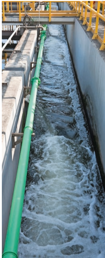
Abwasser Insgesamt werden heute 6,5 Millionen Kubikmeter Wasser gereinigt. Das entspricht 2000 Zofinger Badis – das wäre auch künftig so.
